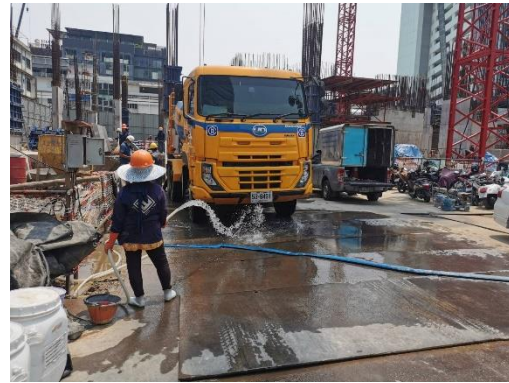
รูปที่ 11 การฉีดล้างล้อรถบรรทุกก่อนออกจากโครงการ
