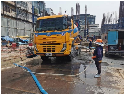
รูปที่ 11 การฉีดล้างล้อรถบรรทุกก่อนออกจากโครงการ
