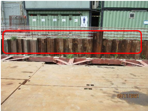
รูปที่ 25 การติดตั้ง Sheet Pile
